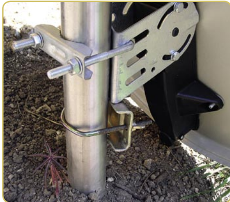
زوج إضافي من أقواس المثبتات لضمان ثبات الطبق عند عملية ضبط التوجيه
